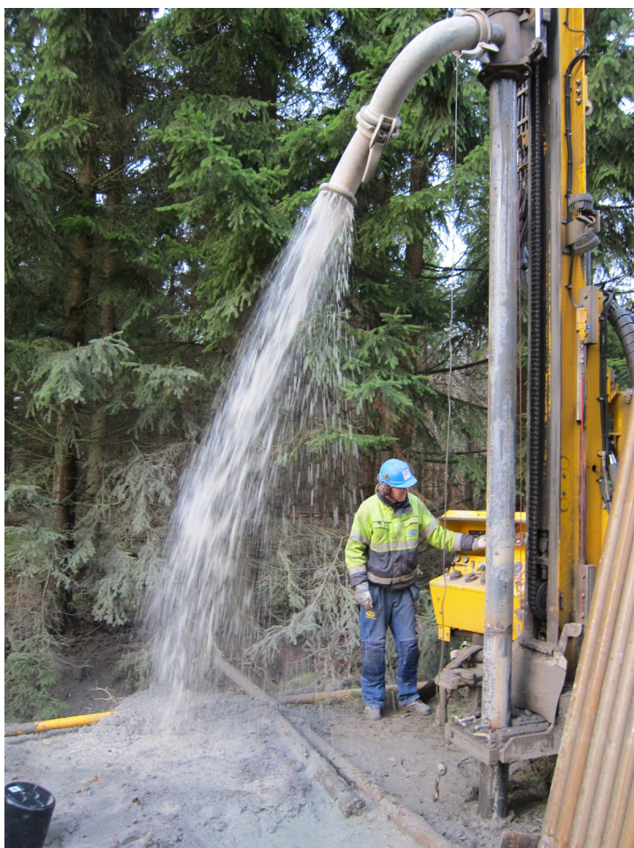
Figur 9. Den rigg som används för borrning är både stor och tung. Det är viktigt för entreprenören att iaktta försiktighet för att minimera skadorna, särskilt på känslig mark. Det är också viktigt att hålla utrustningen i gott skick för att förhindra läckage av olja eller diesel.
